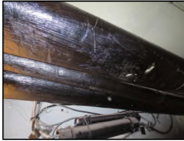
Photo N° 616 ECH-N°2 CALORIFUGEAGE --COULOIR DE CAVE Conduits de fluide Laine minérale + enveloppe bituminée
